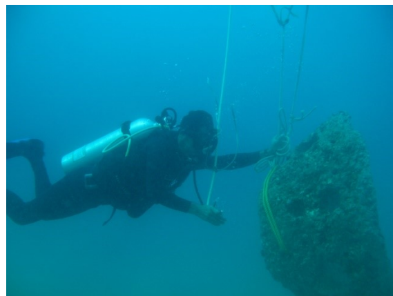
Fig. 5. Bajado de una estructura por medio de cabos y un sistema de liberación gradual.
