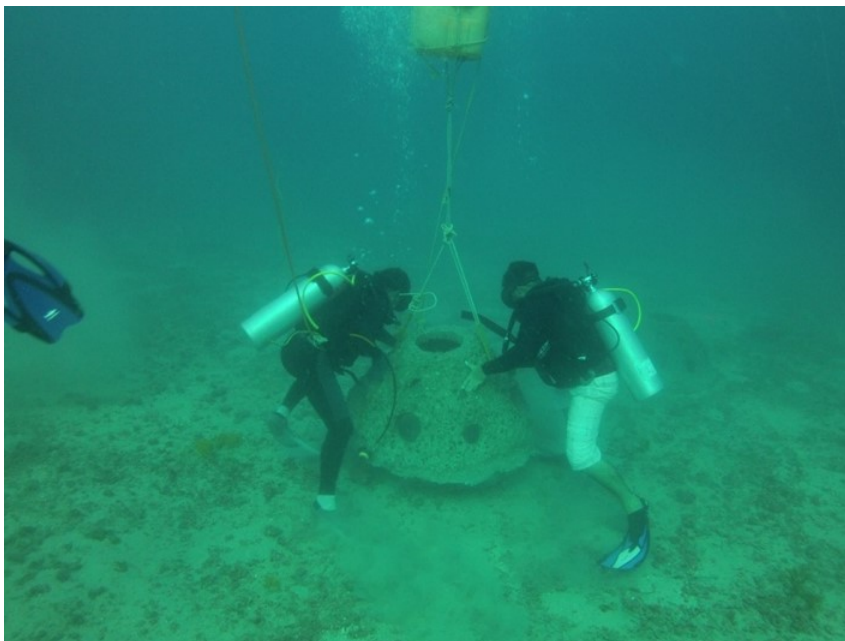
Fig. 8. Colocación de estructura semi-esférica con apoyo de bidones con aire
