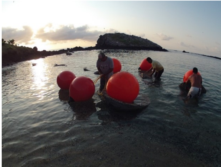
Fig. 4. Estructuras amarradas a boyas inflables listas para remolcarse al sitio de plantado.
