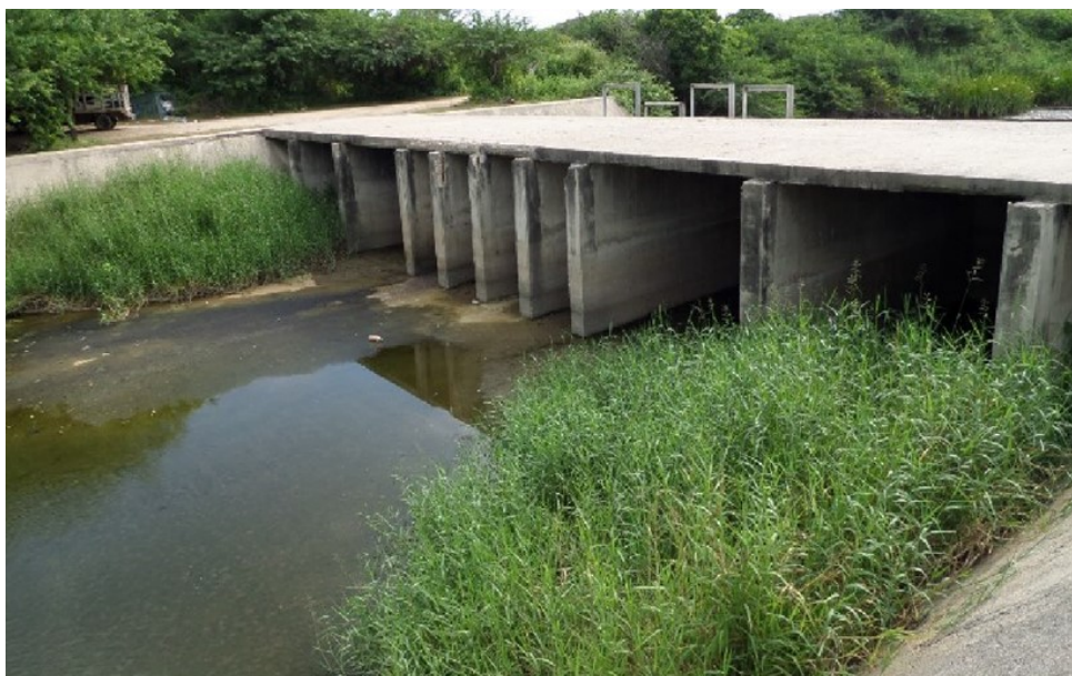
Figura 2. Canal de intercomunicación que controla el flujo y nivel del agua de la laguna Agua Dulce.
