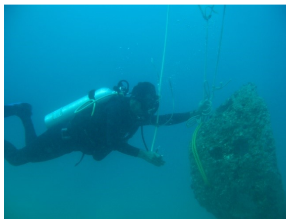
Fig. 5. Bajado de una estructura por medio de cabos y un sistema de liberación gradual.
