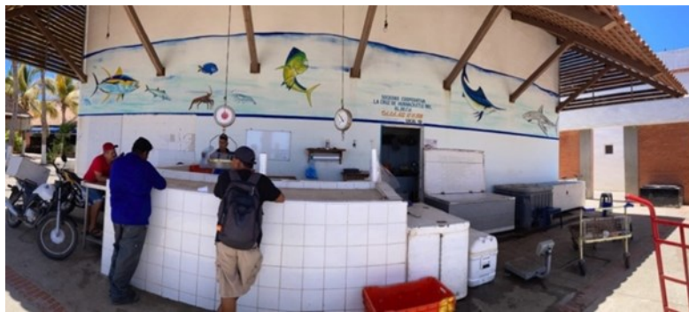
Figura 6. Infraestructura de la SCPP La Cruz de Huanacaxtle
