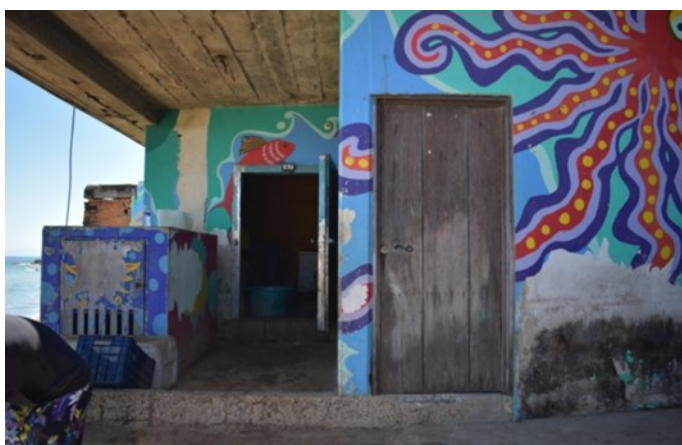
Figura 3. Infraestructura de la Cooperativa Ribera de Suchitán. Centro de acopio.
