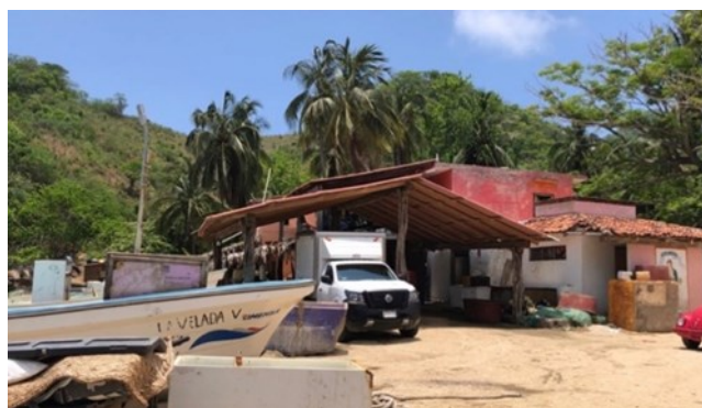
Figura 1. Infraestructura de la SCPP Cabo Corrales SC de RL.
